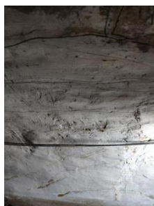
图21 拱顶裂缝
