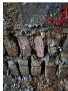
图22 砂浆脱落
