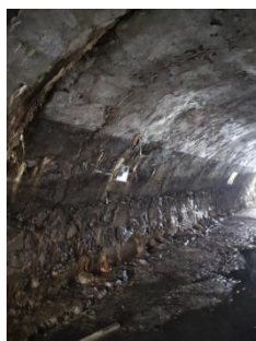
图19 侧墙渗漏
