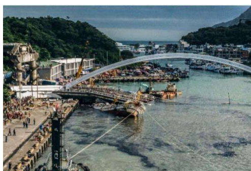
图3 南方澳跨海大桥倒塌事故 [19]
