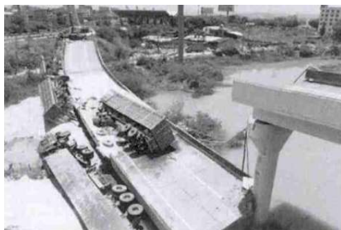
图4 粤赣高速河源城南出口匝道桥倒塌事故 [20]
