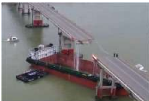
图5 沥心沙大桥倒塌事故 [27]
