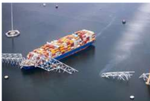
图6 Francis Scott Key 大桥倒塌事故 [27]
