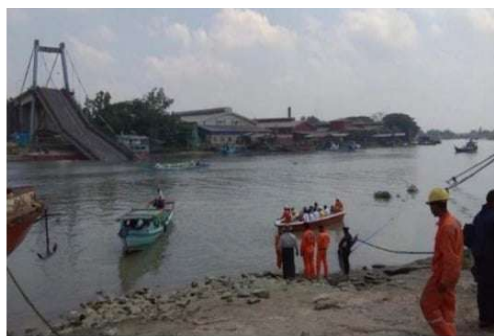
图8 Myaung Mya 大桥倒塌事故 [45]
