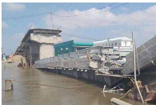
图9 越南某大桥倒塌事故 [49]
