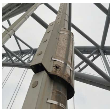
(a) 既有吊杆外附灯罩
