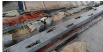
图4 预制混凝土板
