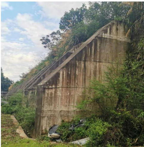
图12 黄祁高速公路体外扶壁加固既有挡墙
