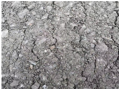
图1 水泥稳定碎石基层开裂现象
