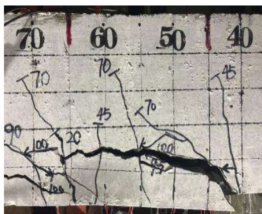
图 11 增设无预应力段加固试件 P-L1400+400 的破坏形态
